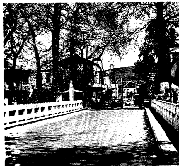
Εικ. 102. Βρύσες Αποκορώνου. Η γέφυρα του παλαιού δρόμου Χανίων-Ρεθύμνου.
