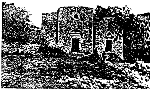
Εικ. 196. Κατωχώρι Κυδωνίας. Τα Φραγγομονάστια. (Girola Monumenti ecc. IV, 609).
