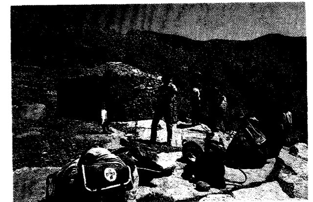
Εικ. 42. Το Μητάτο. Ποιμενικό οίκημα, κτισμένο και στεγασμένο με εντόπιες πέτρες, χωρίς συνδετική ύλη, στις βόρειες πλαγιές τού Ψηλορείτη
